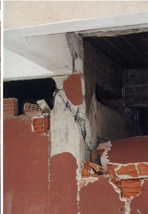
تشکیل ستون کوتاه به دلیل عدم رعایت حاصله مناسب بین میانقلاب و ستون
