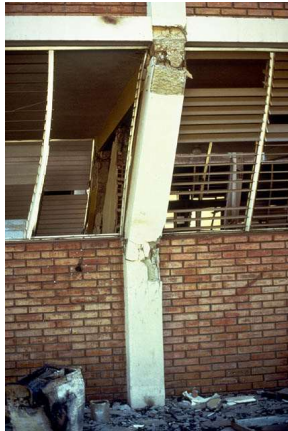
تشکیل ستون کوتاه به دلیل عدم رعایت حاصله مناسب بین میانقلاب و ستون
