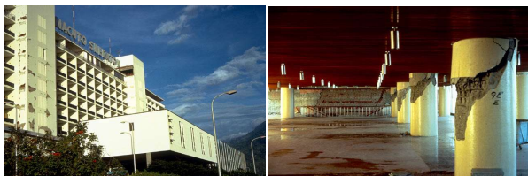
تمرکز فرایی در یک یا چندین طبقه به دلیل عدم پیوستگی سفتی و مقاومتی در ارتفاع ساختمان
